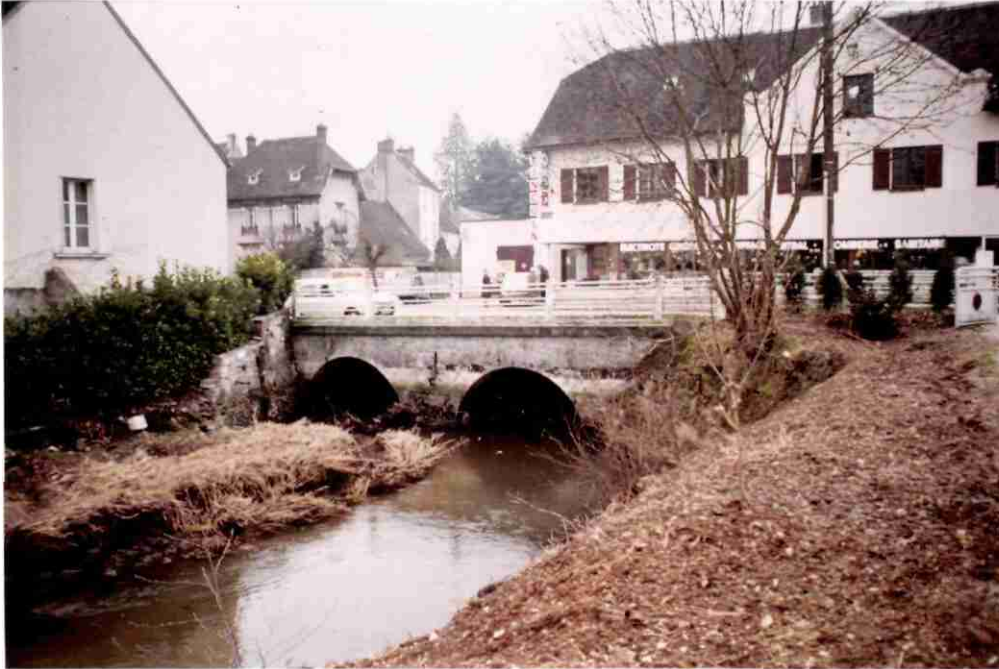
Canal d'amenée Passage sous la route avant l'en- trée dans la chambre d'eau
