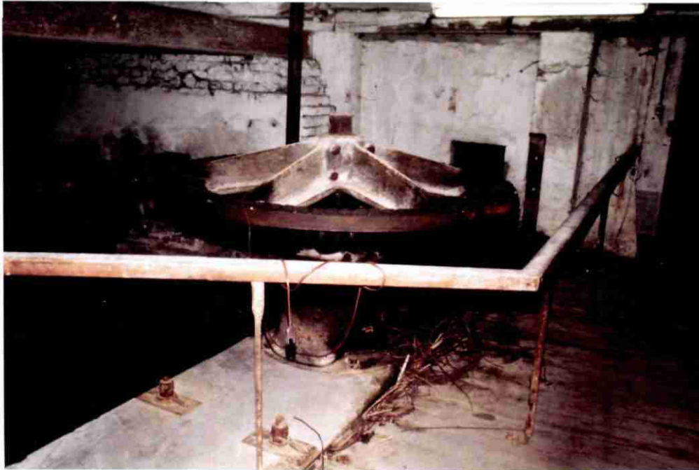
La chambre d'eau Vue du multipli- cateur à dents en bois
