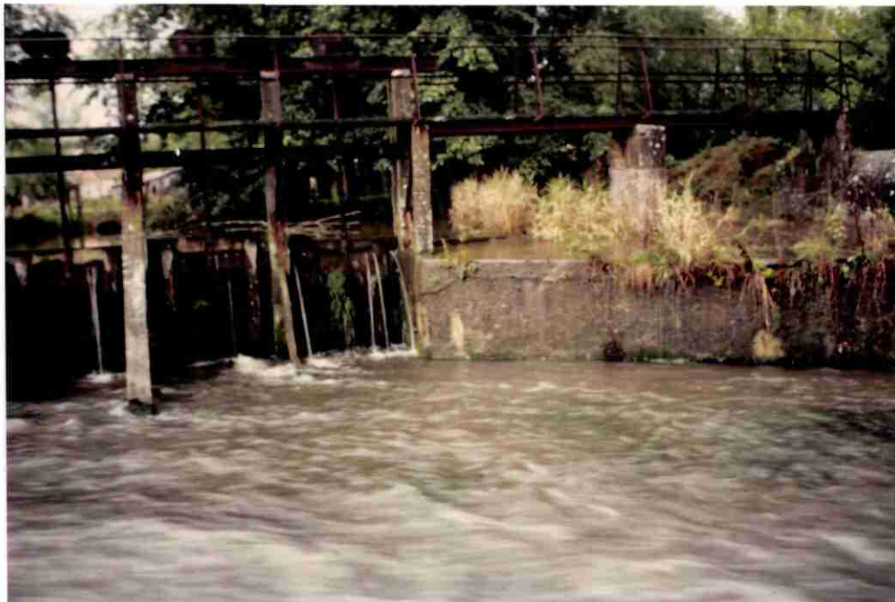
La prise Vannes de décharge et déversoir à seuil fixe
