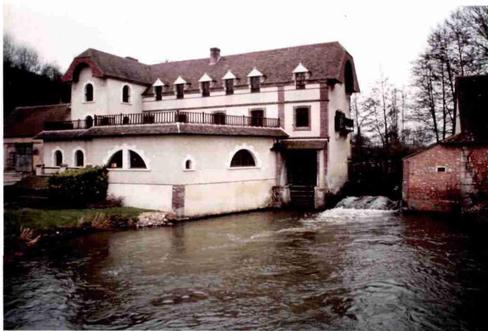
Vue depuis l'aval La roue du moulin et le déversoir vanné
