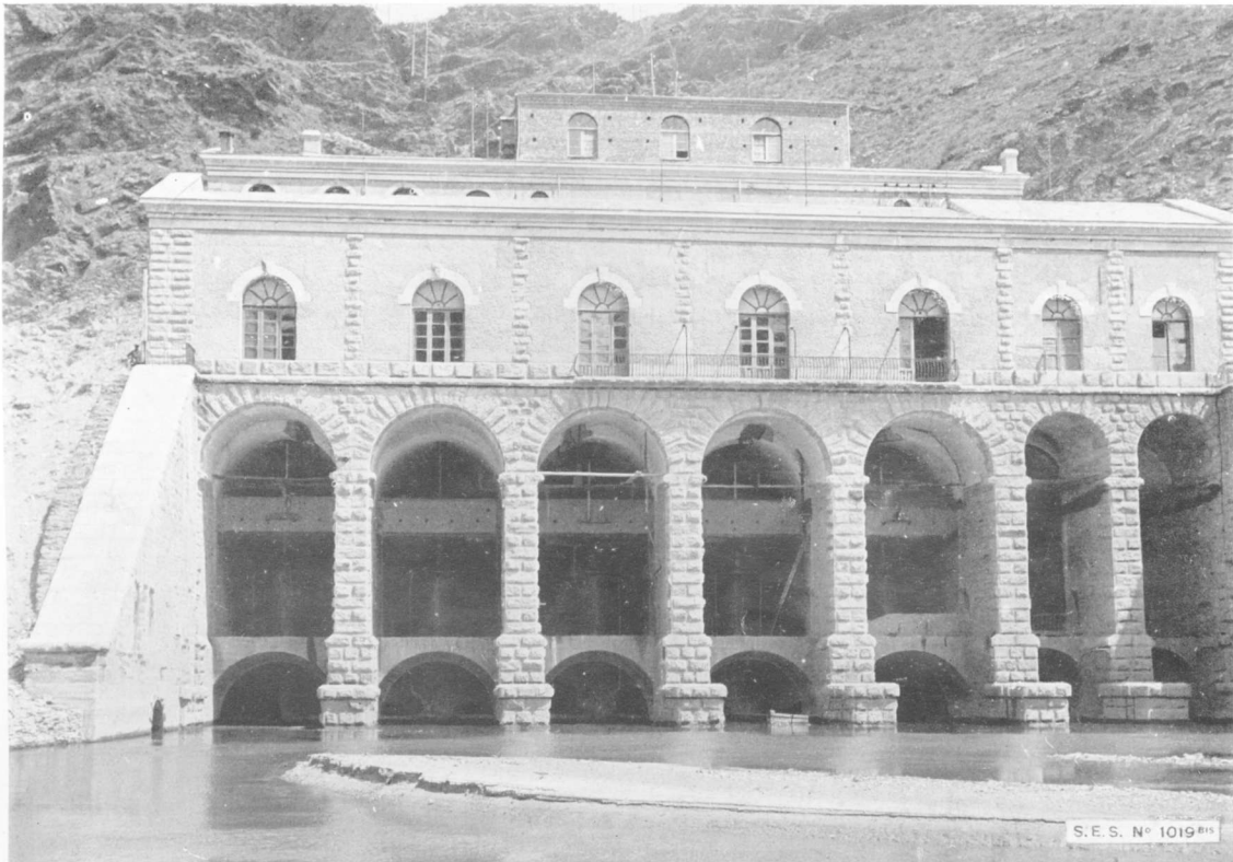
(Fig. 11). — Vue extérieure de la station centrale de 7.200 ch x .
